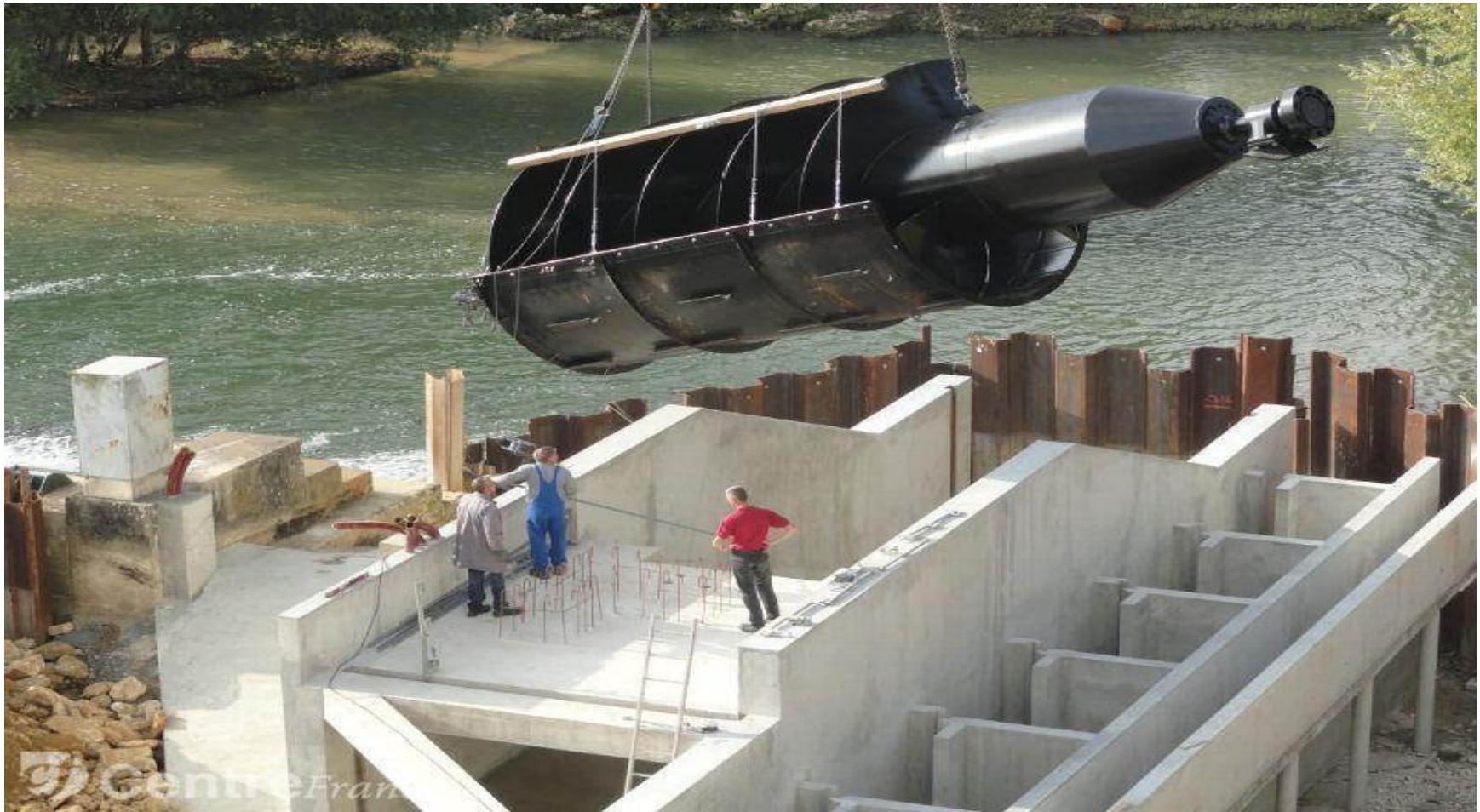
Забота о сохранении рыб на гидроэлектростанции в Brienon-сюр-Armancon не ограничилась строительством рыбохода. Здесь также установлена экологически «чистая» турбина - Архимедов винт, который позволяет рыбе безопасно его пройти. Мощность турбины сравнительно невелика – она выдает 450000 кВт /год, что достаточно для обеспечения энергией 150 домов
