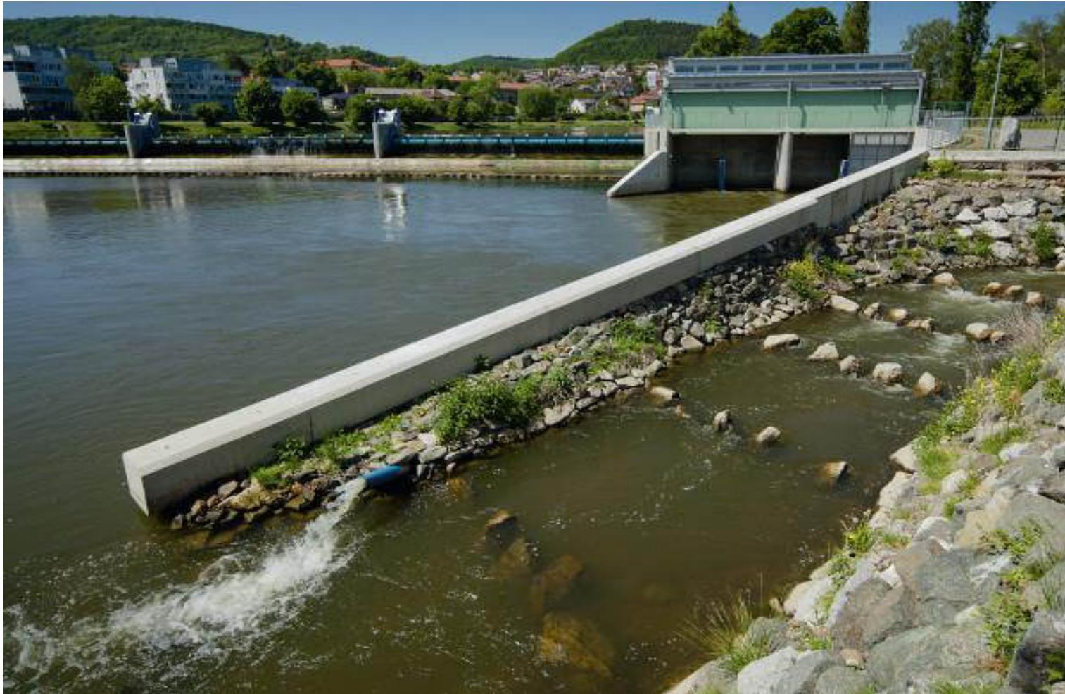
В Чехии на притоке Влтавы реке Бероунка построена одноименная ГЭС ( $4 \times 180$  кВт). Для обеспечения двусторонней миграции рыб был построен рыбоход с порогами подобными естественным. Его длина составляет 128 м, перепад высоты 2 м, с расходом 1 м<sup>3</sup>/с. Видна труба, подающая дополнительный расход воды для создания привлекающего потока
